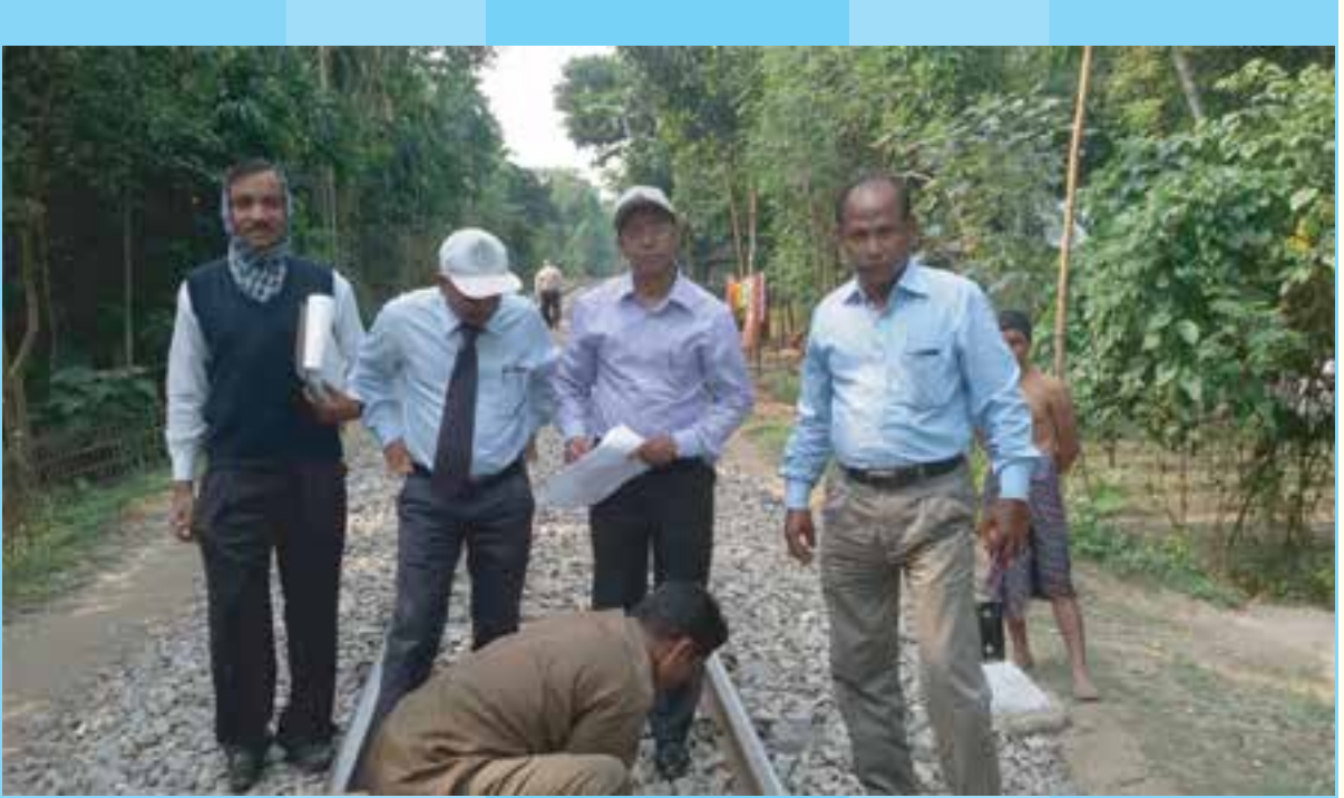
সরকারী রেলপরিদর্শক কর্তৃক লালমনিরহাট-বুড়িমারী সেকশনের ট্র্যাক পরিদর্শন (২০১৪)
