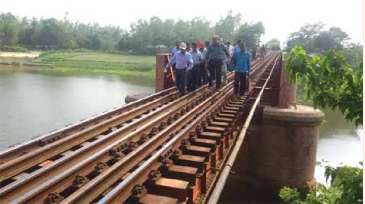
সরকারী রেলপথ পরিদর্শক কর্তৃক ঈশ্বরদী-জামতেল সেকশনের ব্রীজ নাম্বার ২৭ পরিদর্শন (২০১৫)
