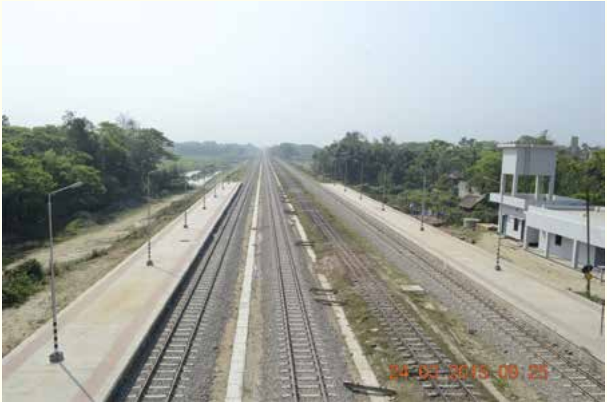
লাকসাম-চিন্‌কি আস্তানা সেকশনের ডাবল ট্রাক নির্মাণ প্রকল্পের আওতায় নির্মিত মুহুরীগঞ্জ স্টেশন ইয়ার্ড
